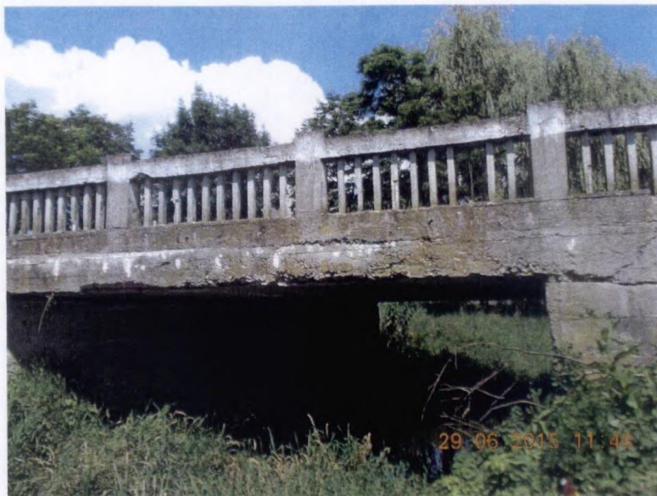
FOTO 3. ZONE CU BETON EXFOLIAT SI ALBIE PARTIA COLMATATA
